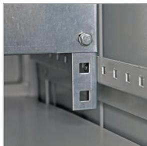
Возможность регулировки глубины установки монтажной панели.
